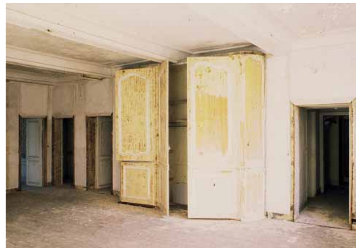
Het 'salon commun', voor en na restauratie.
